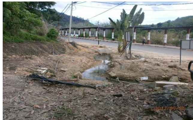
Longkang monsun yang tidak sempurna boleh menyebabkan gangguan terhadap aliran air larian permukaan
