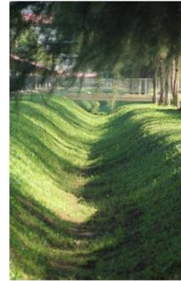
Rajah 9.3 : Reka Bentuk Swale Bagi Mengurangkan Larian Air Permukaan
