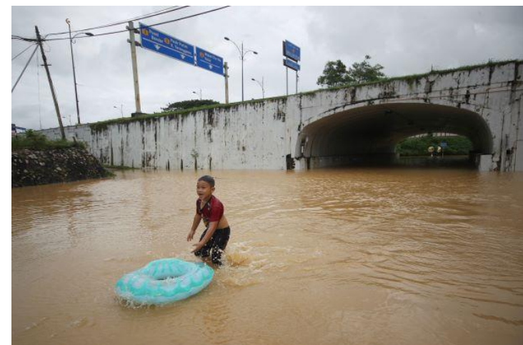
Foto 2.3: Terowong di Jalan Pasir Pekan – Kota Bharu yang ditenggelami air
