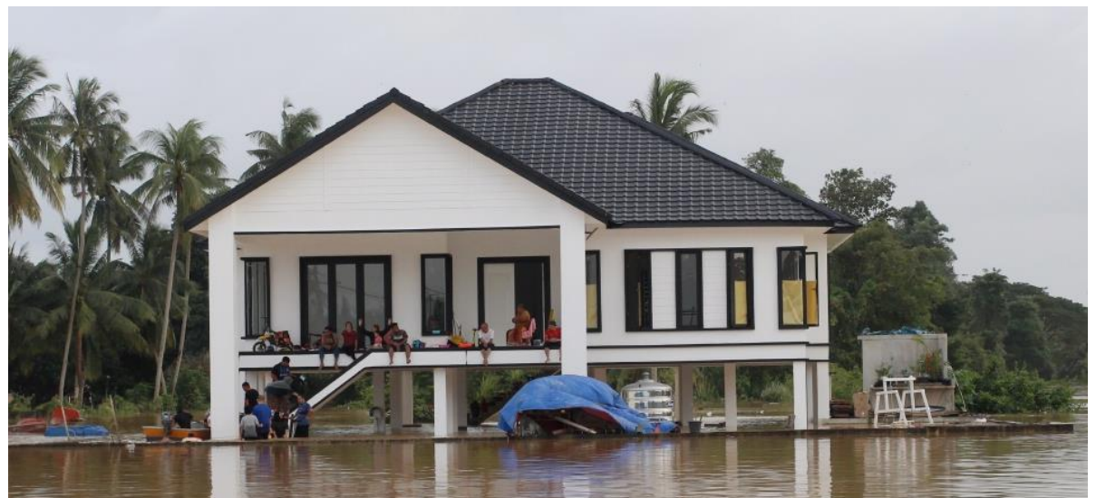
Foto 4.1 : Rumah berkonsepkan on-stilts yang tidak dimasuki air walaupun mencapai ketinggian sehingga 0.8 meter di Kg. Pasir Pekan Hilir, Tumpat
