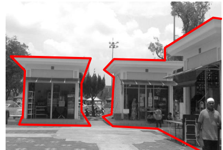
Peletakan Kiosk di luar bangunan utama Masjid.
