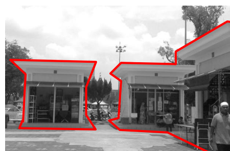
Peletakan Kiosk di luar bangunan utama Masjid.
