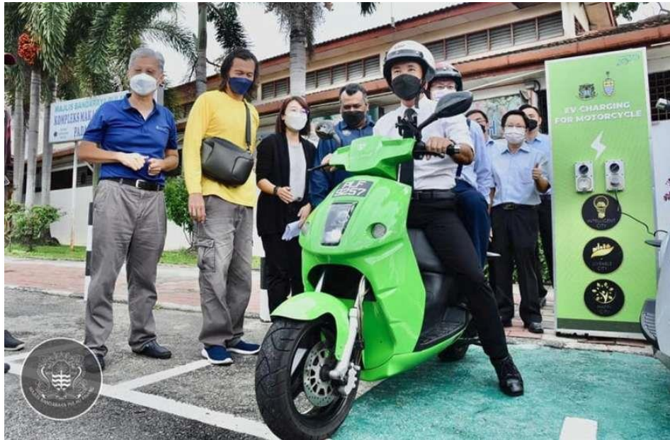
Foto 2 : Stesen Pengecasan Motosikal Elektrik di Pulau Pinang
