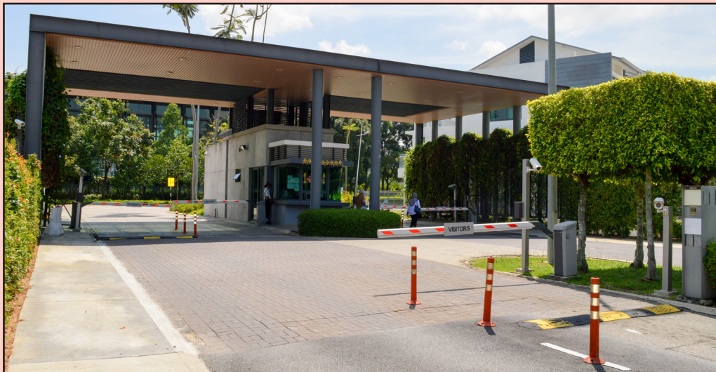
Foto 7: Contoh penggunaan CCTV yang diletakkan di pintu masuk utama ke kawasan SKPS.
