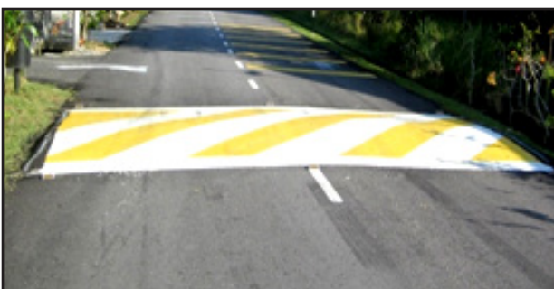
Foto 3 : Spesifikasi pemasangan "speed breaker" dibenarkan mengikut kelulusan dari PBT
