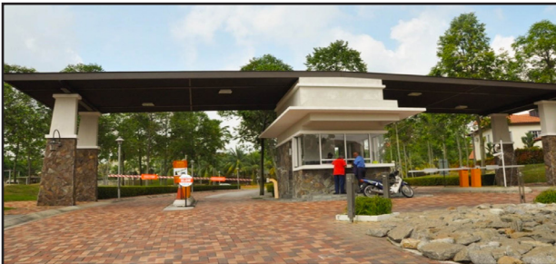
Foto 2 : Struktur berbentuk pintu gerbang adalah tidak dibenarkan
