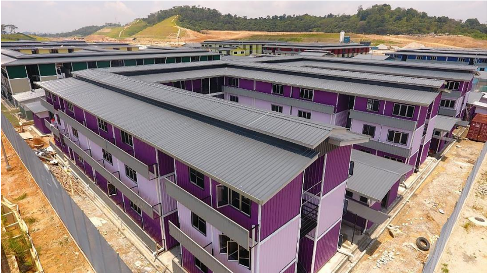
Foto 4 : Contoh Pembangunan CLQ MRT Sungai Buloh, Selangor
