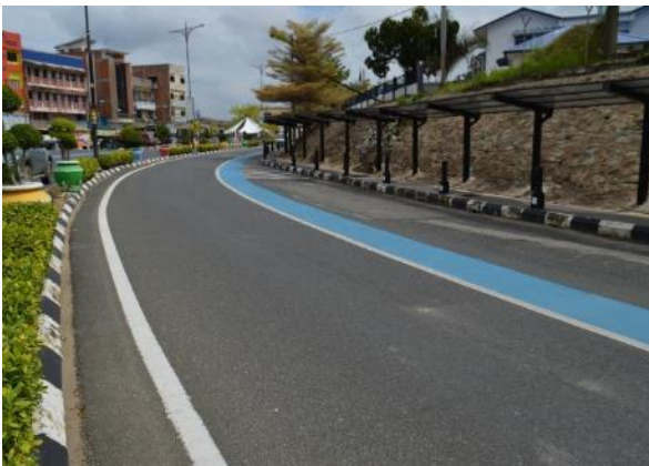
Foto 27: Permukaan berwarna dan anti gelincir bagi laluan kenderaan mikromobiliti on-carriageway
