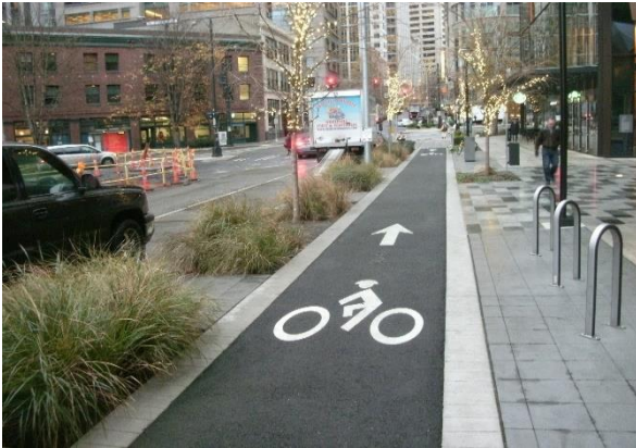
Foto 26: Contoh turapan laluan off-carriageway menggunakan asphalt dan concrete
