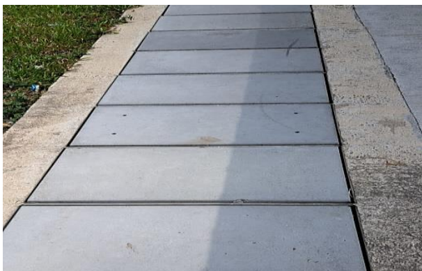
Foto 9: Contoh penutup longkang tertutup dan arah pemasangan penutup longkang
