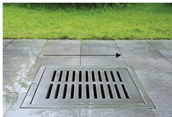
Foto 9: Contoh penutup longkang tertutup dan arah pemasangan penutup longkang
