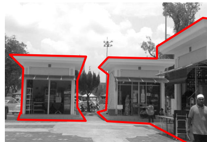
Peletakan Kiosk di luar bangunan utama Masjid.
