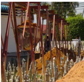
Konsep 'bucket railing' untuk mengangkut pasir dan tanah ke tapak kubur sedia ada.
