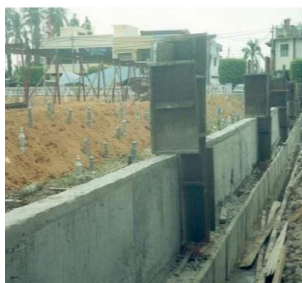
Pembinaan struktur tembok penahan dan sistem saluran air bawah tanah di perkuburan sedia ada
