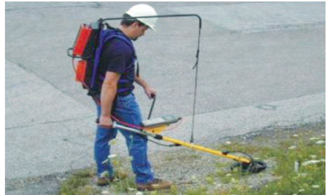
Foto 10: Kerja pengesanan laluan utiliti bawah tanah sedia ada.
