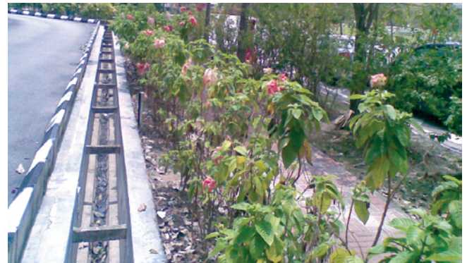
Foto 8 dan 9: Laluan kemudahan utiliti di dalam rizab jalan yang tidak berturap.
