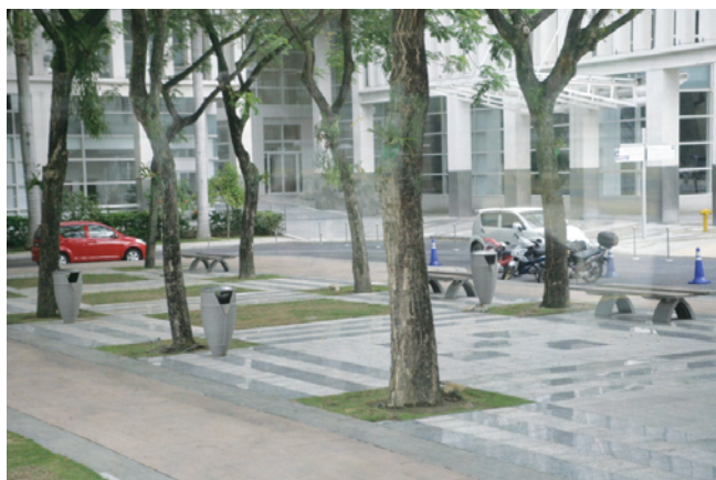
Foto 4: Persekitaran yang bersih dan indah dengan penempatan laluan utiliti di bawah tanah.
