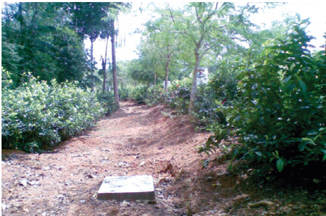
Foto 2: Penempatan laluan utiliti bawah tanah tanpa saluran terowong tapi berkongsi laluan bersama.
