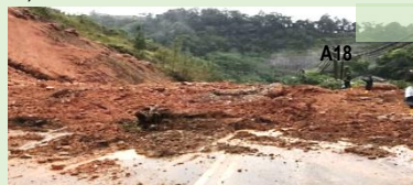
Kejadian tanah runtuh di Cameron Highlands, Pahang.
