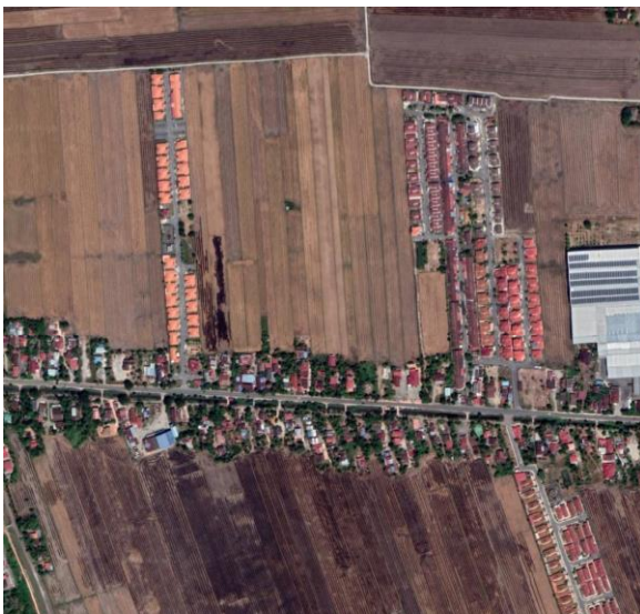
Contoh pembangunan lot lidi di Kubang Pasu, Kedah
