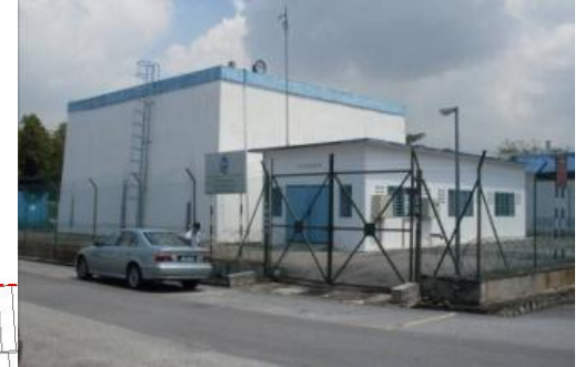
Cadangan Loji Rawatan Air Baru Changkat Lobak, Beriah Kapasiti : 40 JLH Intake : Sg. Kerian Luas : 3.7868 hektar Lot Terlibat : 395-398, 904 & 7814
